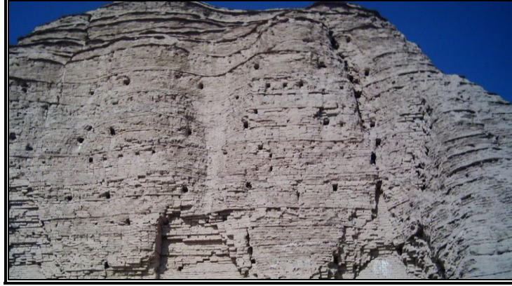
صورة توضح الثقوب والخروق الموجودة في الزقورة
